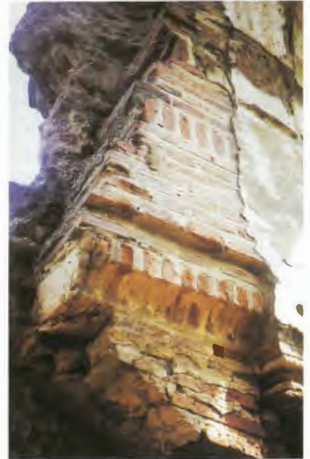
Muro de ladrillo contiguo a la capilla de San Benito.
